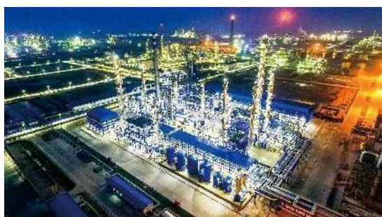
11. 东营港石化基地 Dongying Port Petrochemical Base
